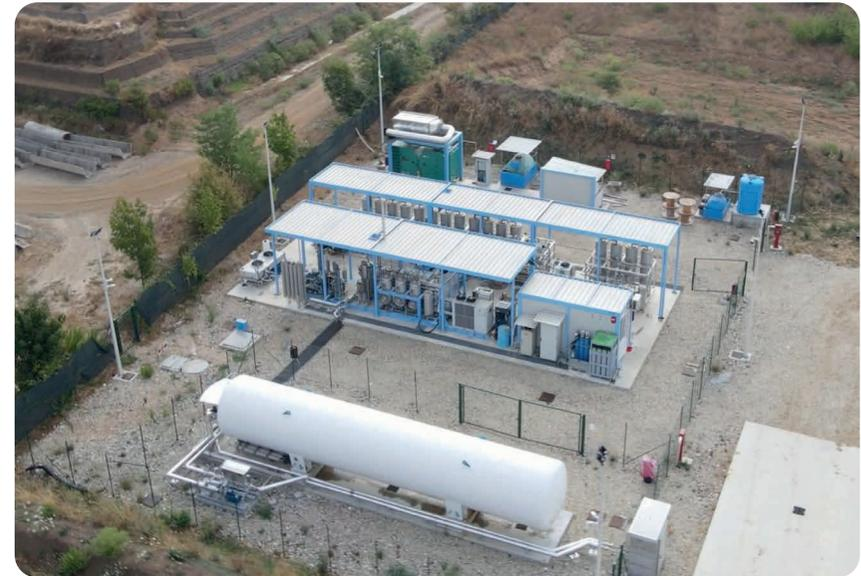
Novi Ligure – Discarica gestita da SRT S.p.A Biogas upgrading + liquefazione biometano & storage
